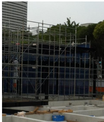
鉄骨組み立て中
